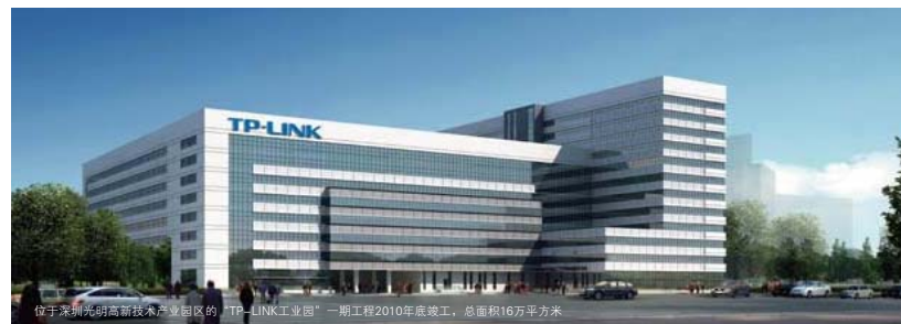
位于深圳光明高新技术产业园区的“TP-LINK工业园”一期工程2010年底竣工，总面积16万平方米
